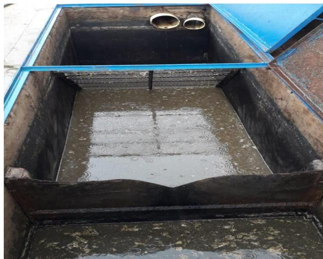
**Figura 4** – Caixa de decantação de efluente do abatedouro utilizado no processo de compostagem, nos tratamentos C e D
